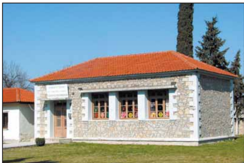
Το πρώην δημοτικό σχολείο και πλέον νηπιαγωγείο
